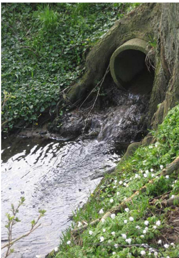
Kloakudløb i vandløb ved Laksevej i Langå.
