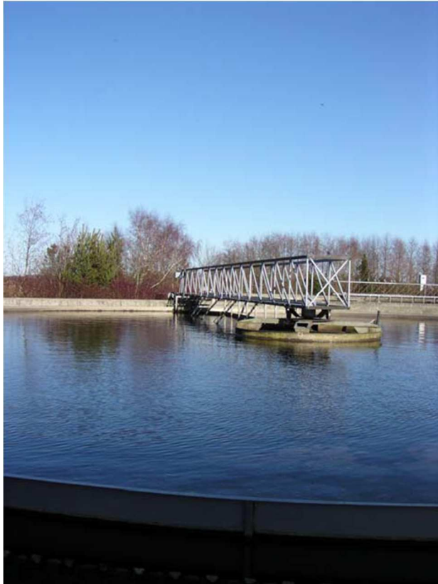
Klaring tank på Langå Rensning anlæg.
