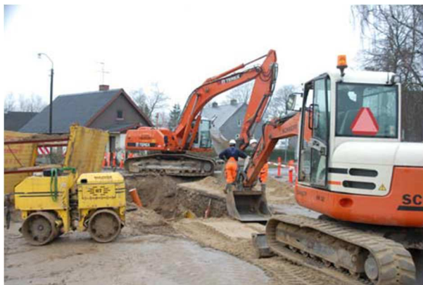
Kloakarbejder i Råby.
