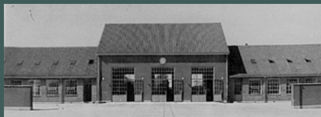
Oprindelige udvendige forhold mod syd
