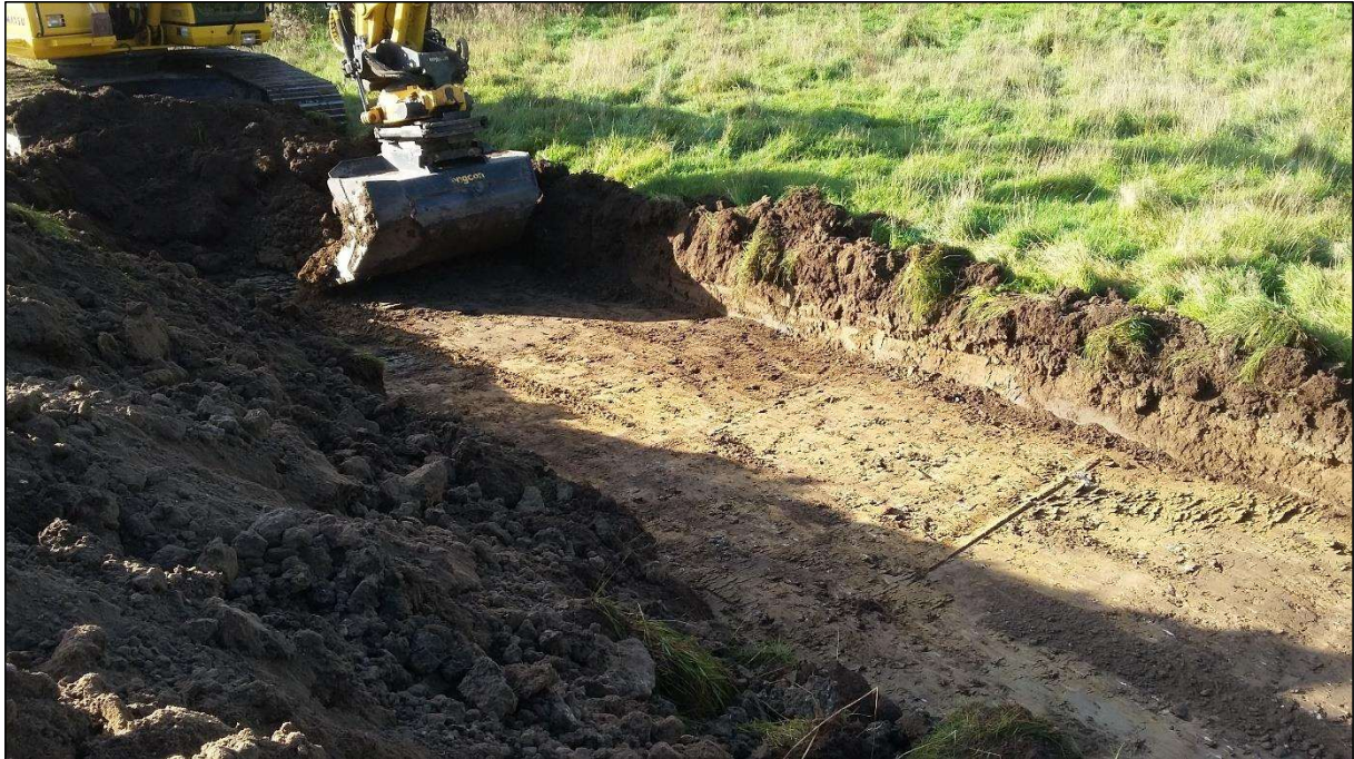
Figur 4: Undergrunden bestod af let sandet ler, flere steder med mange sten og indslag af grus.
